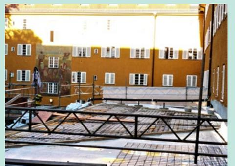
Auf die Betonfläche wurde wieder eine Folie verlegt. Um den Betonboden wurde dann eine Randeinfassung konstruiert, die dem Halt des Granulats sowie dem Aufbau des Regenwasserflusses dient. Die Spenglerarbeiten für den Regenwasserabfluss sowie die Integration der Regenabflussrohre vom Dach erwiesen sich als äußerst kompliziert und waren bei Redaktionsschluss noch nicht beendet.
